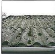
Welleternit und Wellbitumenplatten
